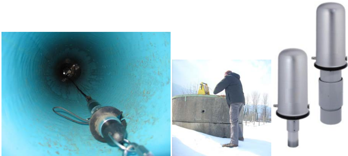
Figura 7. Data logger collegato via cavo a sonda posizionata nella falda in un piezometro (a sinistra), pozzo oggetto di monitoraggio nell'area di pianura del Comune di Cervinara (centro) ed esemplificazione di capsule per l'alloggiamento dell'acquisitore e del sistema di teletrasmissione dei dati misurati su pozzo.
